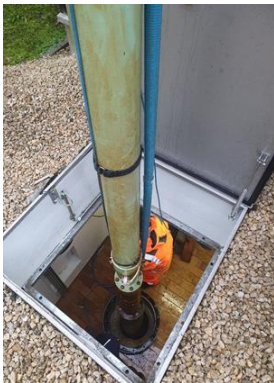
Ausbau Brunnenpumpe
